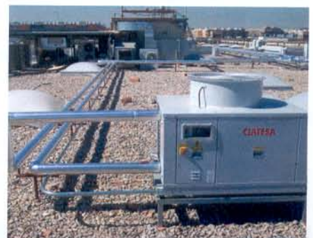
Esquema de principio de la instalación experimental, bomba de calor agua-agua y grupos hidráulicos, bomba de calor aire-agua sobre la cubierta del edificio.
