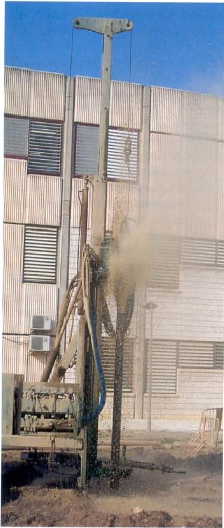
Excavación de los pozos.
