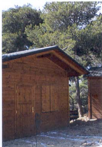
BUNGALOWS CON INSTALACIÓN GEOTÉRMICA DE ENERGESIS
