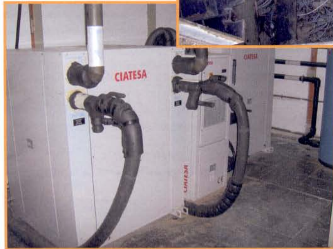
Foto 5. Bombas hidráulicas y bombas de calor
